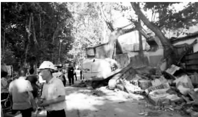
图为拆迁现场
